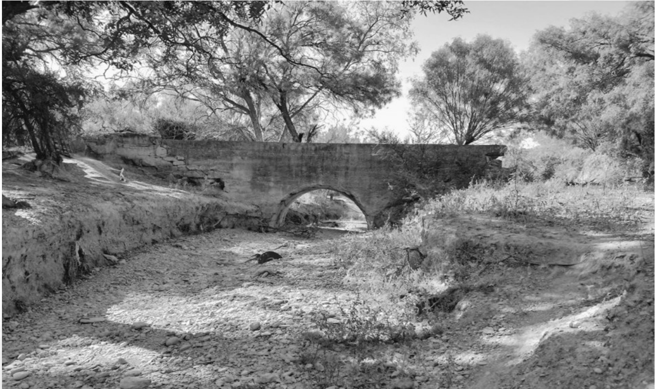
Monumento Histórico (1875, arquería) de una de las obras hidráulicas de la Acequia Madre Olivares, ubicada a la altura de la Loma de “doña Paula”, construida a base de mampostería. Ubicada en el arroyo que descarga al río Escondido antes del “Pico del Águila”. Fotografía. González Gorjux Francisco Javier:
